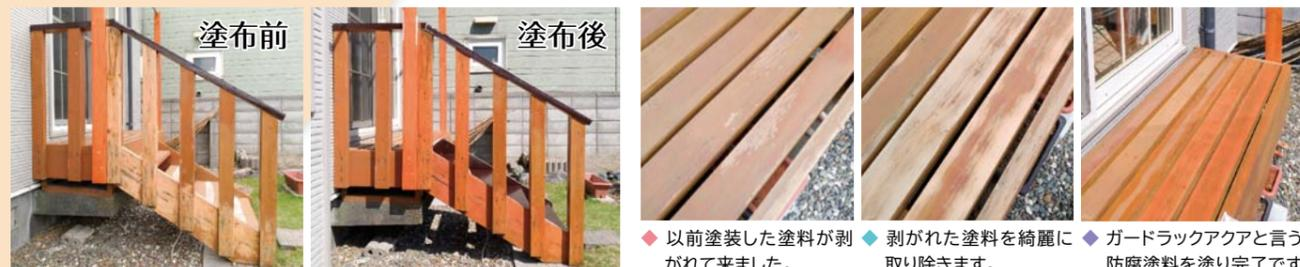
◆ 以前塗装した塗料が剥がれて来ました。 ◆ 剥がれた塗料を綺麗に取り除きます。 ◆ ガードラックアクアと言う防腐塗料を塗り完了です。
