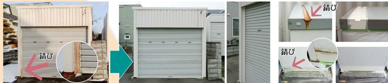
ガイドレール周りに錆びが出ています。本来なら、錆止め処理をすべき所ですが、DIYでは錆止め入りの鉄部ペイントを使用します。
