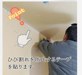
クロス部分の下地処理をします
