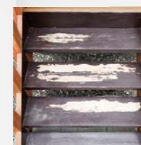
下地処理前の状態です。以前に塗った塗装を剥がさず上塗りした為剥がれてきました
