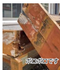
階段の取り付け部分の傷みがひどいため補修せず交換としました
