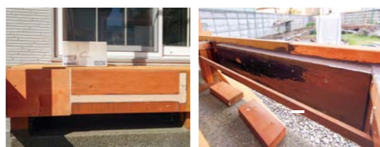
前板全てを交換したい所でしたが、どうしても使う事のできない部分のみ交換しました。裏から当て板(再利用)をビスで固定し、一体化させるガセット接続と言う手法を使用しました
