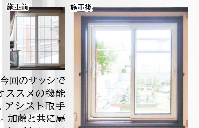
■内側から見た状況です。四方に化粧枠を取り付け、一業種で終わるように工夫しました
