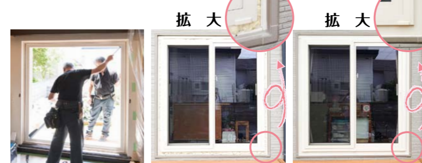
■サッシの対角を確認します。この作業は非常に重要です。ひし形に出来ないように確認する作業です ■サッシの隙間にウレタンを充填します。あとは、既存の枠との隙間にアルミのカバーを取り付けコーキングをして終了です
