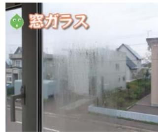
この症状はペアガラスの中の乾燥空気が漏れ、ペアガラスの性能が大きく低下している状態です。この様な状態だと熱が窓ガラスから大きく逃げてしまいますので、ガラスの交換をお勧めいたします。
